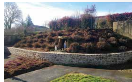
Cimetière / Les Châtelliers-Châteaumur : construction d'un mur de soutien
