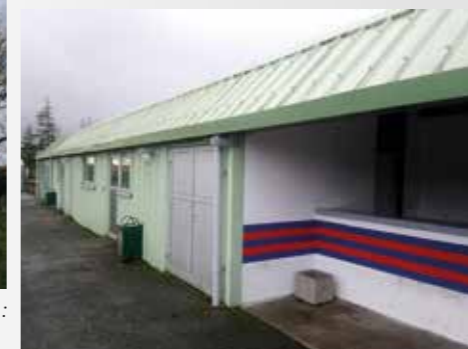
Vestiaires du stade / Les Châtelliers-Châteaumur : remplacement des gouttières
